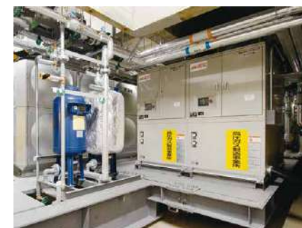
湯野浜温泉街の中心部ある熱交換システムの集中給湯機械室
